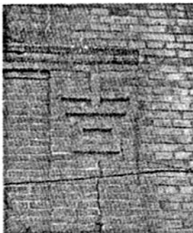
图2 坝下地区墙体样式
