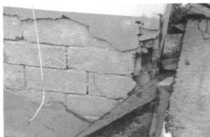
图5 角部无构造柱
