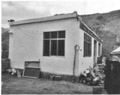
图7 外檐脱落
