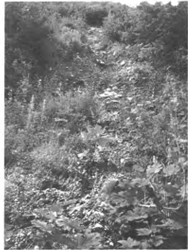
图3 吃水沟泥石流斜坡流滑
