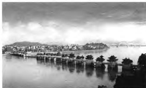
图1 浮梁结合结构
