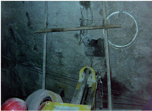
图 4 多点位移计安装 Fig. 4 Installation of multipoint displacement meter
