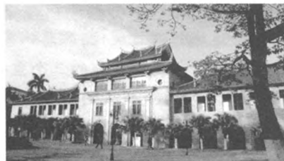
图1 厦门大学群贤楼群主楼
