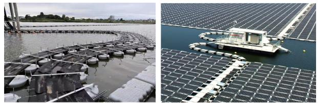
图7 S型漂浮电缆通道
