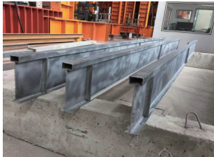
图 2 浇筑完成的试验梁
