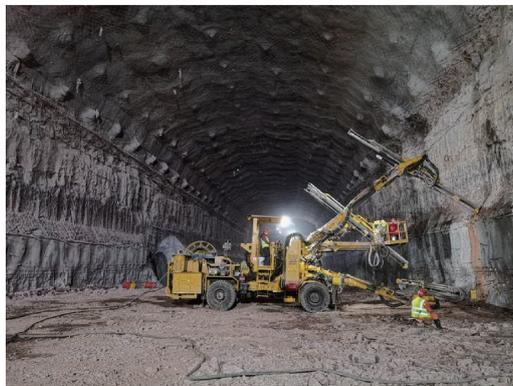
(a) 工程爆破常用多臂凿岩台车
